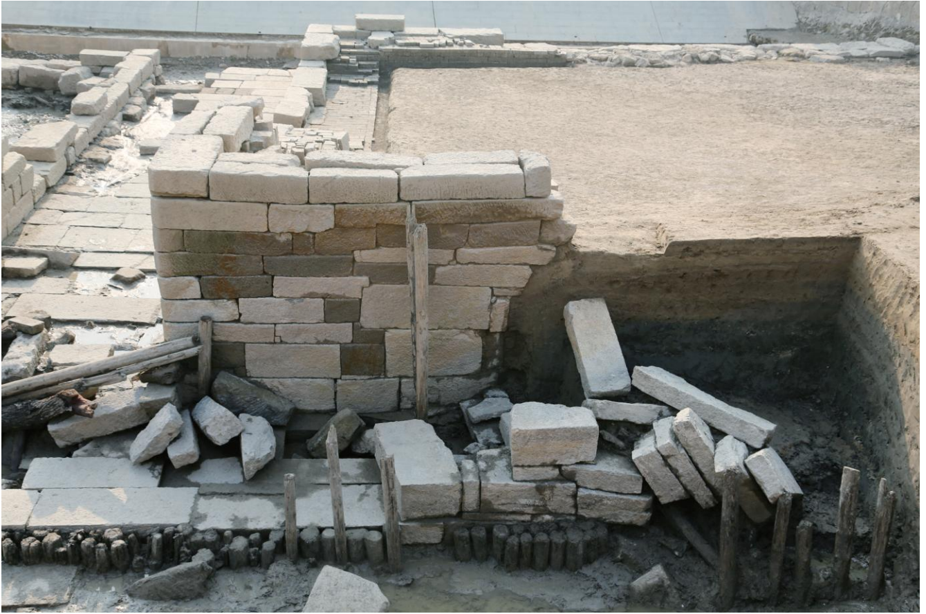
图五// 出水口北立壁西侧墙体与夯土
